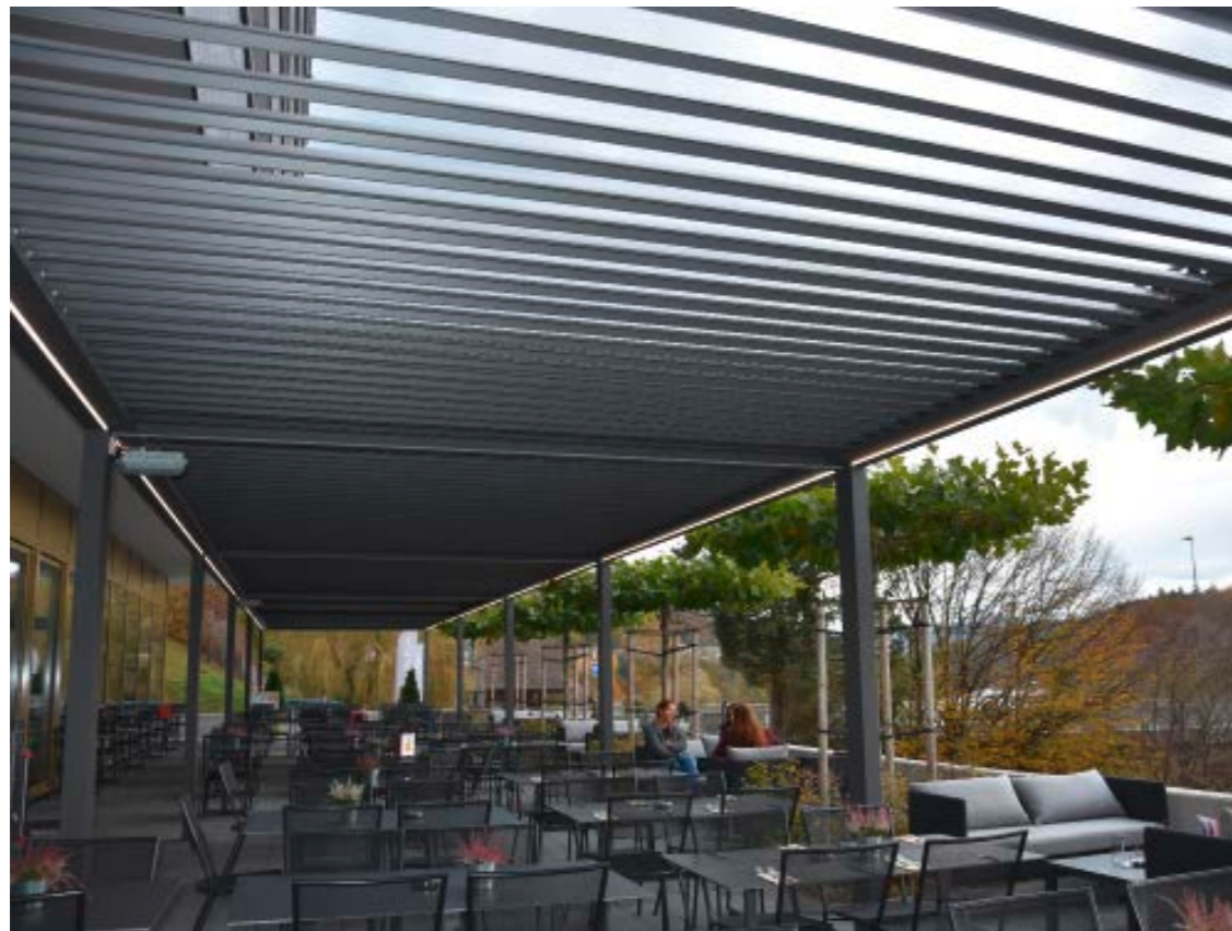
Anbau oder freistehend? Für Thermogreen kein Problem. Auf der Terrasse des Ristorante Lago installierte das Unternehmen ein S-Design-Lamellendach mit sechs Modulen und insgesamt 14 Stützen. Die Steuerung der Lamellen erfolgt via Fernbedienung.
